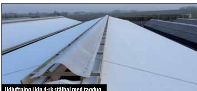
Udluftning i kip 4-rk stålhal med tagdug
