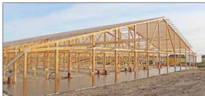
Mėšlo kanalų montavimas
